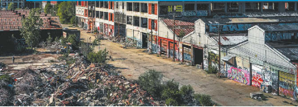
↑1 デトロイトの廃工場（ミシガン州，2018年4月撮影） 自動車の王国だったが，2013年に財政破綻した。現在は再建の途にある。
