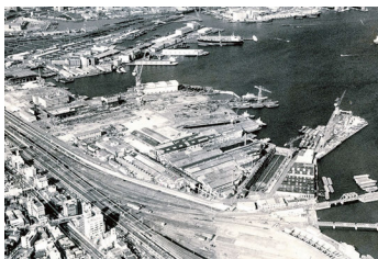
大規模な造船所跡 (横浜市, 1983年2月撮影) 造船所は1982年に市内の本牧・金沢地区に移転した。
