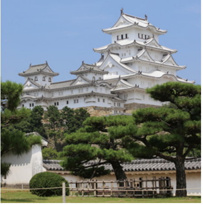
6 姫路城 関ヶ原の戦いののち、池田輝政が着工し、1609(慶長14)年に竣工した。姫山にそびえる平山城で、連立式の天守となっている(本丸・西の丸が現存)。別名白鷺城。(兵庫県)
