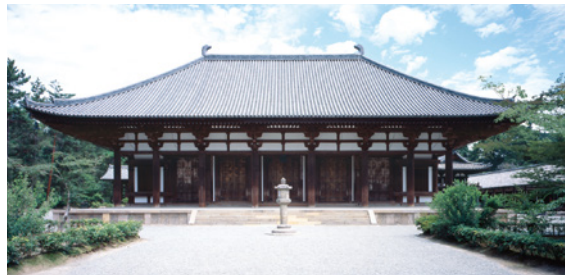
6 唐招提寺金堂 唐招提寺は鑑真の創建。金堂は奈良時代建築の代表で、前面に吹き放しの柱を8本ならべ、外側ほど柱の間隔をせましく、重い屋根を支えている。770年代。(正面約28m。奈良県)
