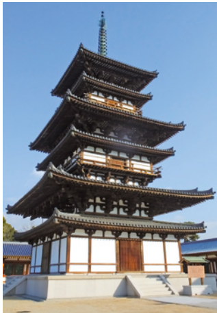
1 薬師寺東塔 三重塔の各層に裳階という小さな屋根がついて、六重塔のようにみえる。730(天平2)年ごろの建築だが、白鳳期の様式を伝えているとされる。(高さ約34.1m。奈良県)
