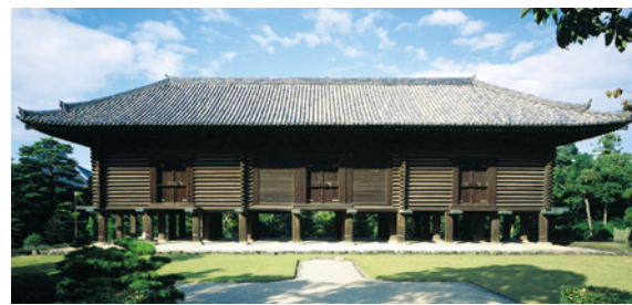
7 正倉院宝庫 もと東大寺の倉。左から南倉・中倉・北倉で、南北両倉は三角材を横にして壁を組みあげた校倉造の構造をもつ。(正面約33m。奈良県)
