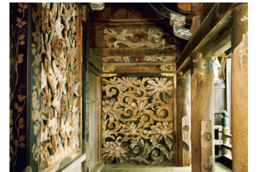
都久夫須麻神社本殿 琵琶湖の竹生島にある。入母屋造・檜皮葺の建物で、伏見城内の殿舎を移建したとも伝える。屋根の唐破風、豪華な透彫をほどこした扉など、桃山時代の華やかな趣をよく示す。(滋賀県)
