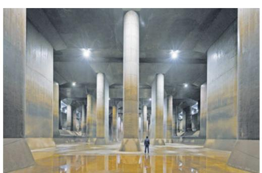
↑9 地下20mにつくられた首都圏の大雨時用の貯水施設(埼玉県春日部市, 2018年撮影) 大雨で増水した河川の水を一時的に貯めることで、洪水による浸水被害を軽減する。
